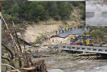
폭우로 무너진 도로와 교량(미국)
